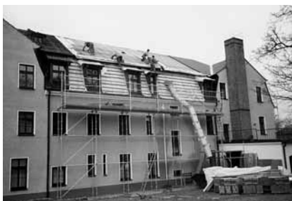
In den Jahren 1989–1992 werden Haupt- und Seitenflügel des ehemaligen St. Josefsheims zum Gäste- und Exerzitienhaus umgebaut
